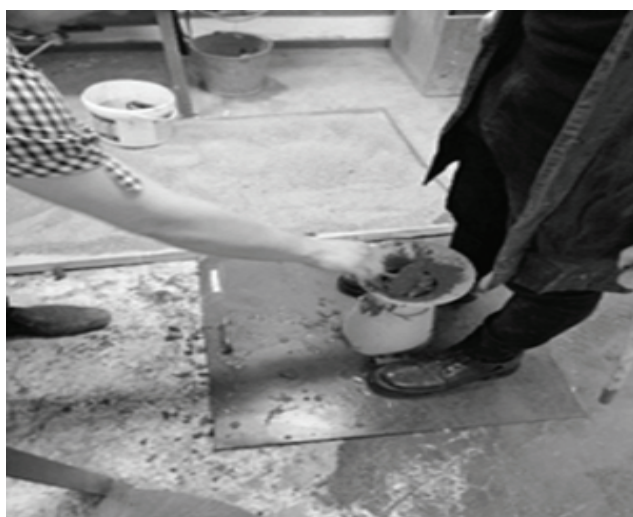
Рис.1. Получение цементной штукатурки
